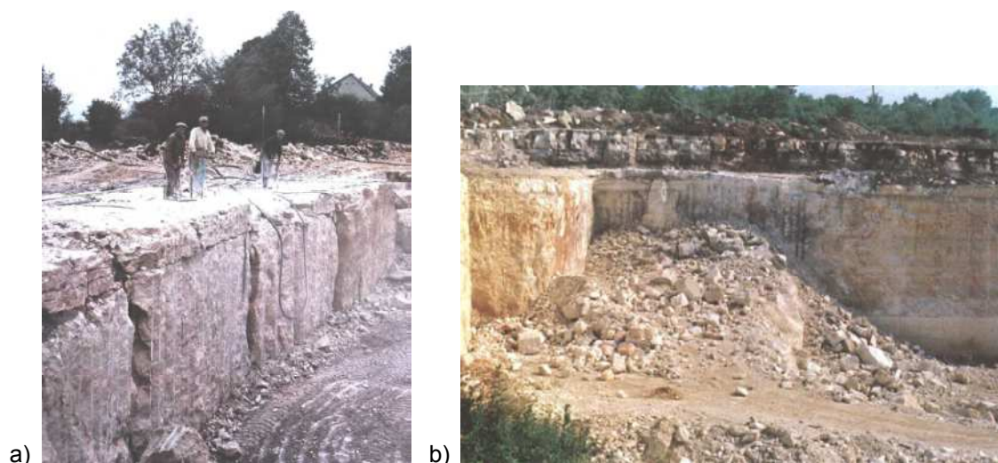
Slika 1 Uklanjanje jalovinskog pokrova
